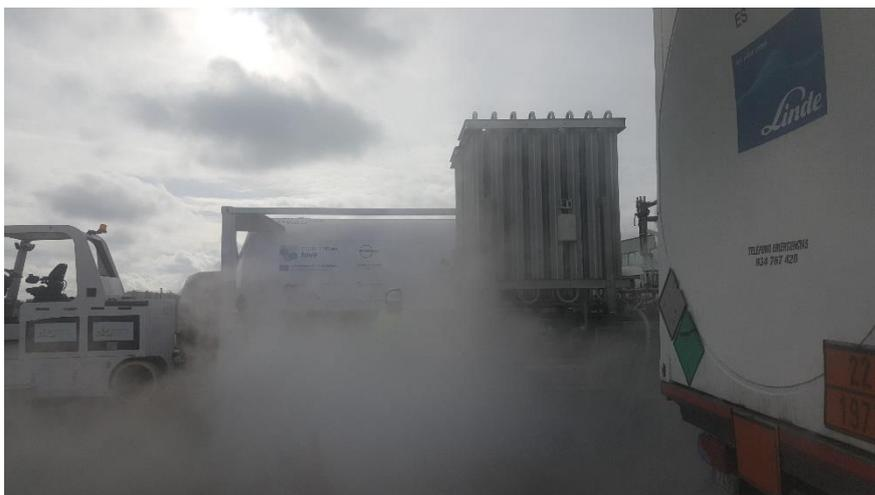
Figura 51 Procedimiento realizado de puesta en frío del isocontenedor
