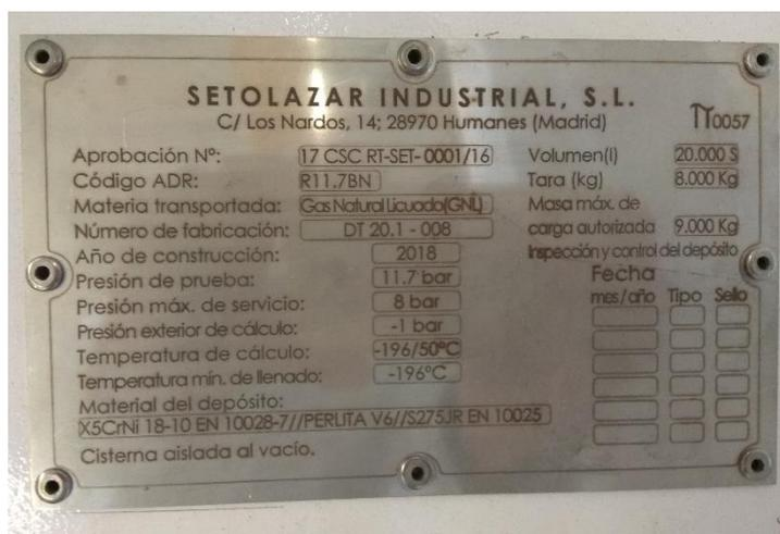
Figura 46 Placas de certificación de seguridad del isocontenedor
