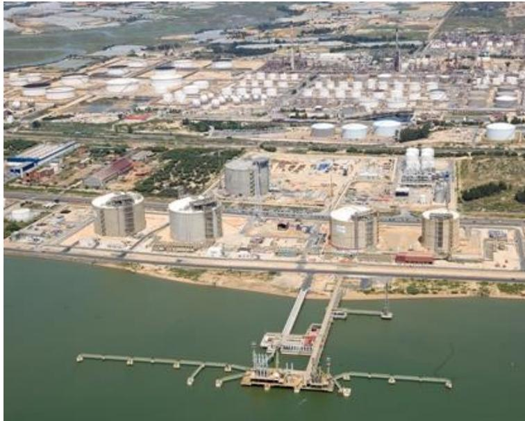
*Figura 55 Planta de regasificación en la APH, con los cargaderos de cisterna disponibles.*
