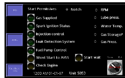
Pantalla del sistema de control del motor
