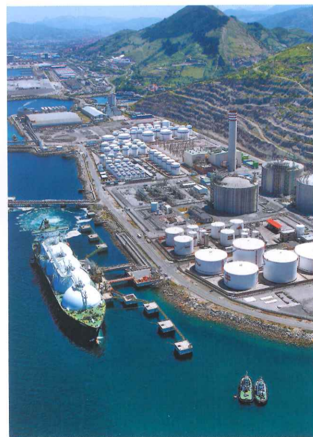
LNG Facilities at the port of Bilbao.
