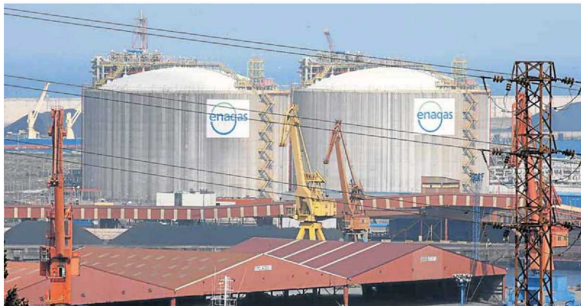
Los tanques de la regasificadora de Enagás sobresalen en el puerto de El Musel. :: DAMIÁN ARIENZA
